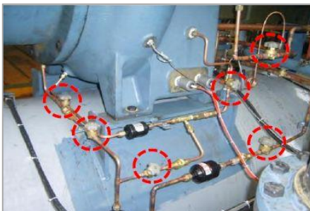
2) ОТКРЫТЬ клапана на фреоновой линии
