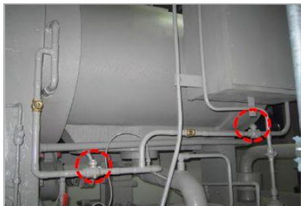
1) ОТКРЫТЬ клапана на масляной линии
